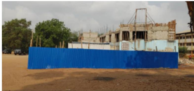
**Photo : Barrière physique sur le chantier pour sécuriser le site**
